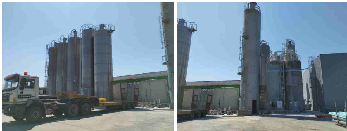
Figure 84 : Photos des silos
