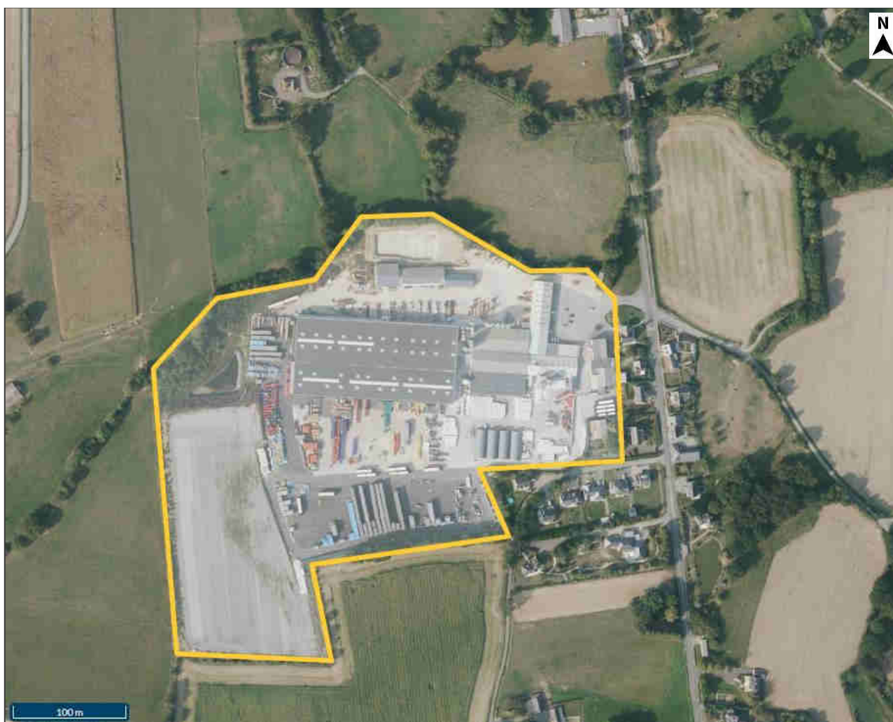
Localisation du site dans son environnement
